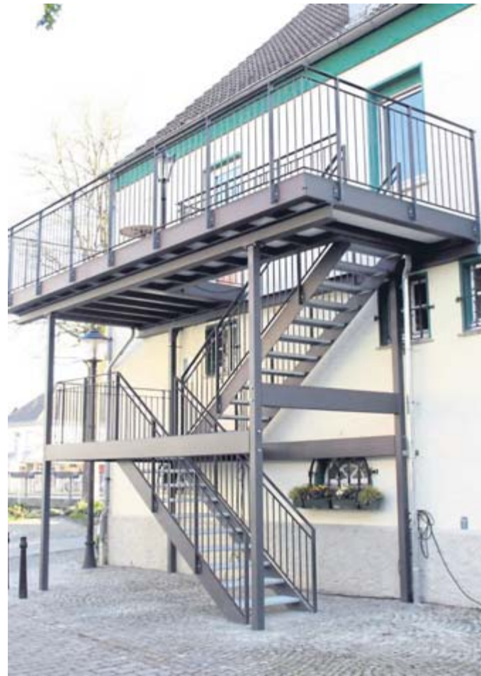
Moderner Hingucker: Der neue Balkon bietet den Gästen einen wunderbaren Blick ins Grüne, durch die neue Außentreppe wurde auch in Sachen Brandschutz alles auf den neuesten Stand gebracht. Auf die optisch sehr gut zum Gebäude passende Treppe ist auch die verantwortliche Firma Elbracht stolz.
